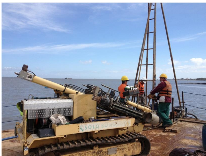
Figura 5 Sondagem rotativa em corpo hídrico.
